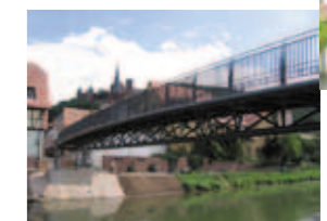
Fußgängerbrücke in Wertheim
