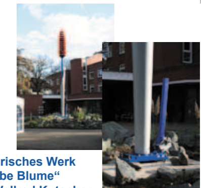
Schwenkantrieb für Wettermast
